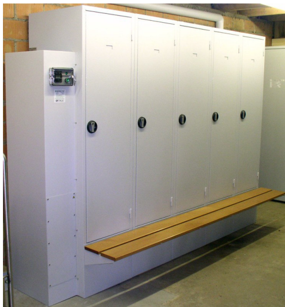
Warmluftgarderobenanlage in einem Landwirtschaftsbetrieb, Notkersegg
