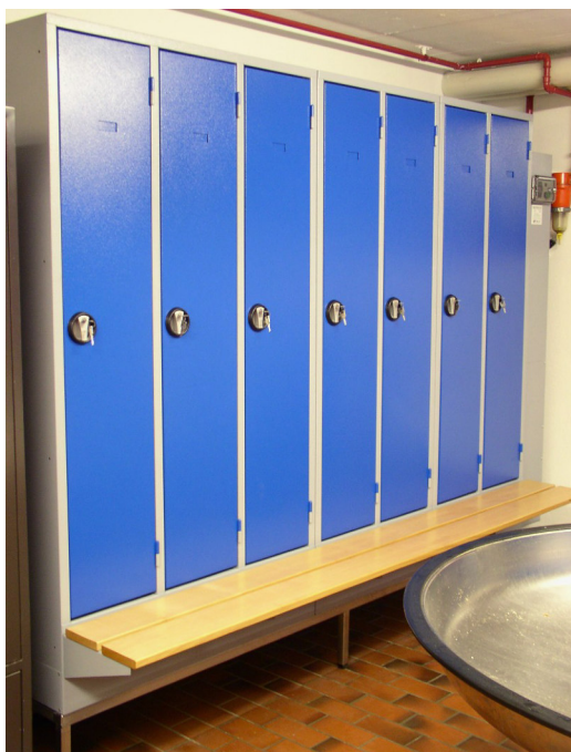
Tiefbauamt AR, Heiden: Warmluft- Garderobeneinrichtung auf Edelstahlgestell
